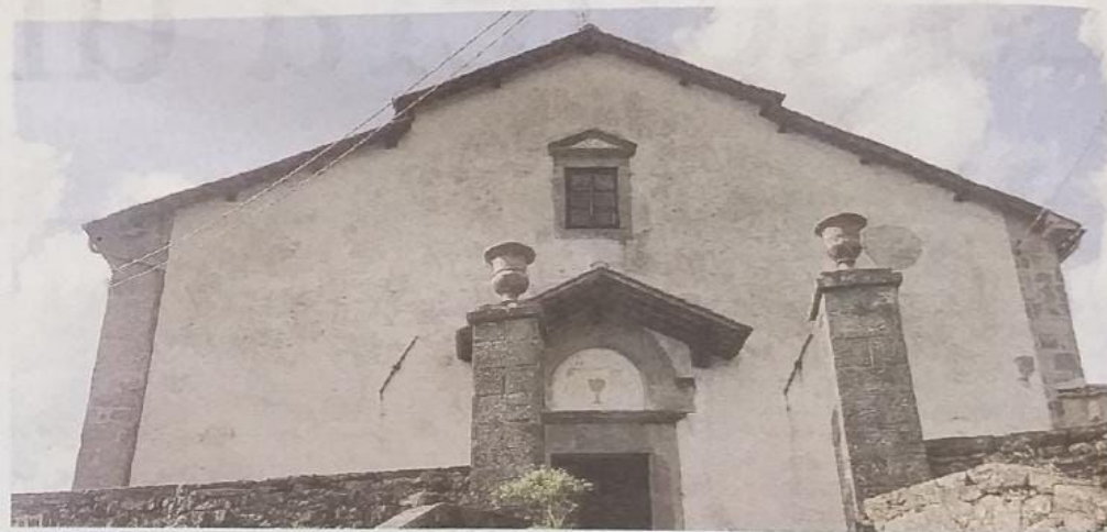
LA FACCIATA Un primo piano dell'esterno della chiesa di San Miniato, punto di aggregazione per il borgo di Calamecca
