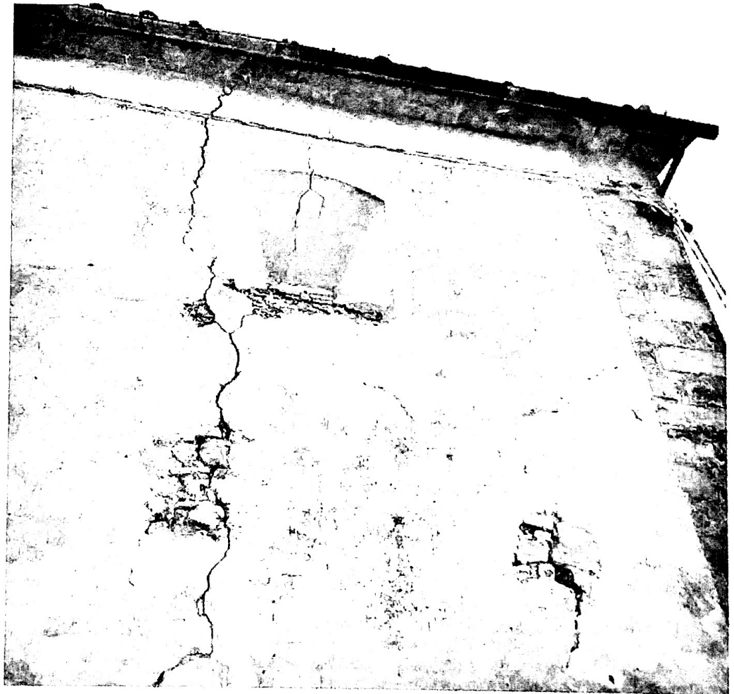
Le grosse crepe su una delle facciate della chiesa di Calamecca
